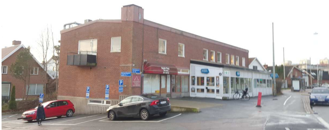
Befintlig byggnad sedd från nordost, Eklandagatan.
